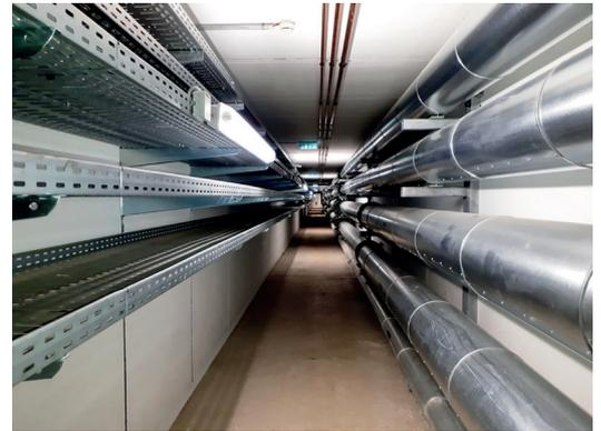
Bild: Unterirdischer begehbare Leitungskanal.
